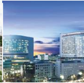
세브라스병원 SEVERANCE HOSPITAL
